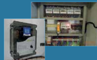
Figuras 8 e 9. A Câmara Municipal de Ansião e a Eneólica estão já a introduzir a medição contínua e simultânea dos sistemas críticos, no sentido de criar uma referência para o seu comportamento.
